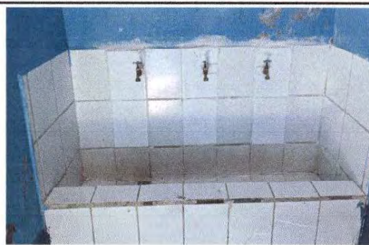
Foto 6: Sustrucción de grifos
