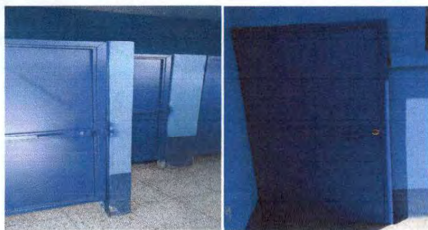
Foto 5: Mantenimiento a estructura (lijado, cambio de tubo, cepillado, sujeciones y aplicación de pintura) a puertas servicios sanitarios. (Hombres y mujeres)
