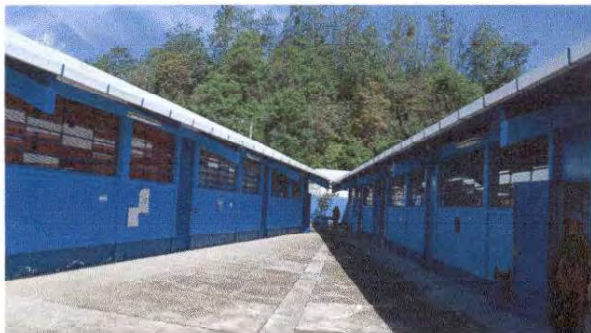
Foto 7: Implementación de canales PVC con soporte o pescantes para canal
