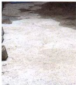
Foto 15: Fundición de torta de cemento
