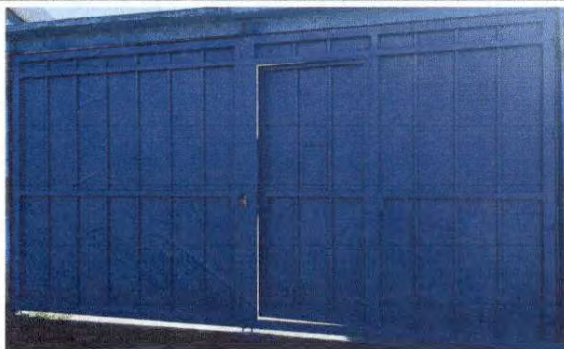
Foto1: Sustrucción de porton principal
