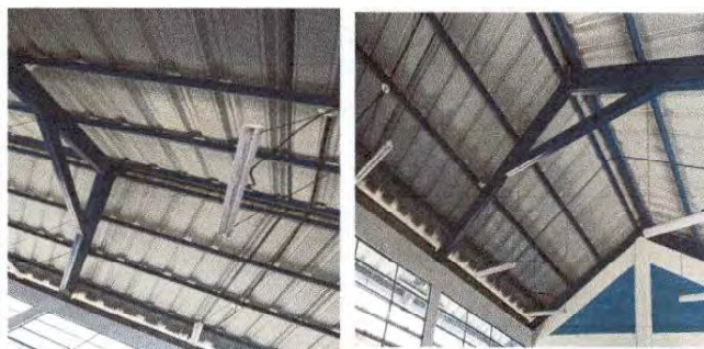
Foto 12: Sustitución de Lámpas LED tipo listón
