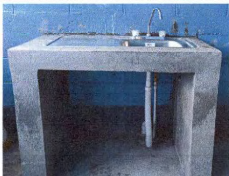
Foto 3: Implementación de lavatrastos (incluye mezcladora)
